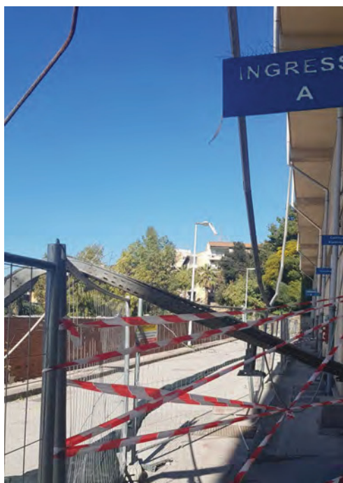
Chiusura lato ingresso Scala A
